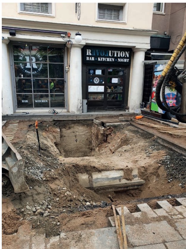
Tonttijohdon korjausta kävelykadulla.
