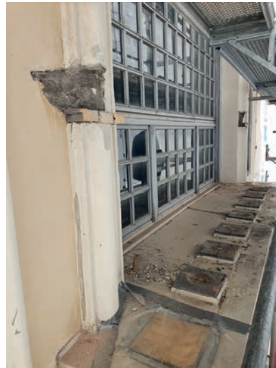
Työväentalon parvekkeen kaide irrotettiin korjauksia varten kokonaisuena.
