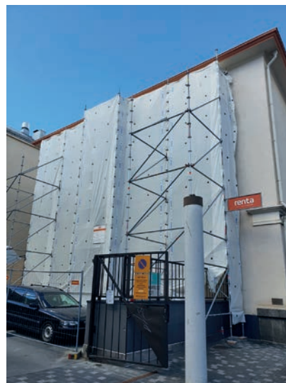
Työmaan sääsuojaus sisäpihan puolella.
