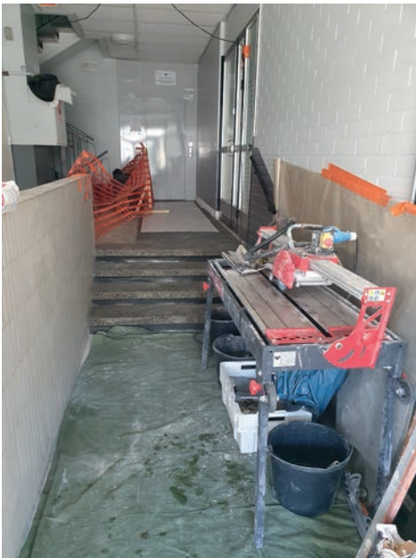
Väinönkatu 7 A-rapun sisäntuloaula remontoitiin huhtikuussa 2022.
