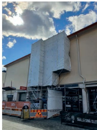
Työväentalon ulkopuoliset korjaukset käynnissä.
