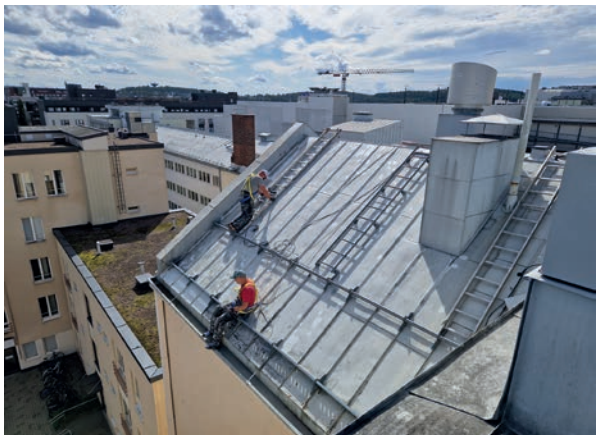
Pelottomat maalarit maalaamassa Kauppakatu 30 kiinteistön kattoa.
